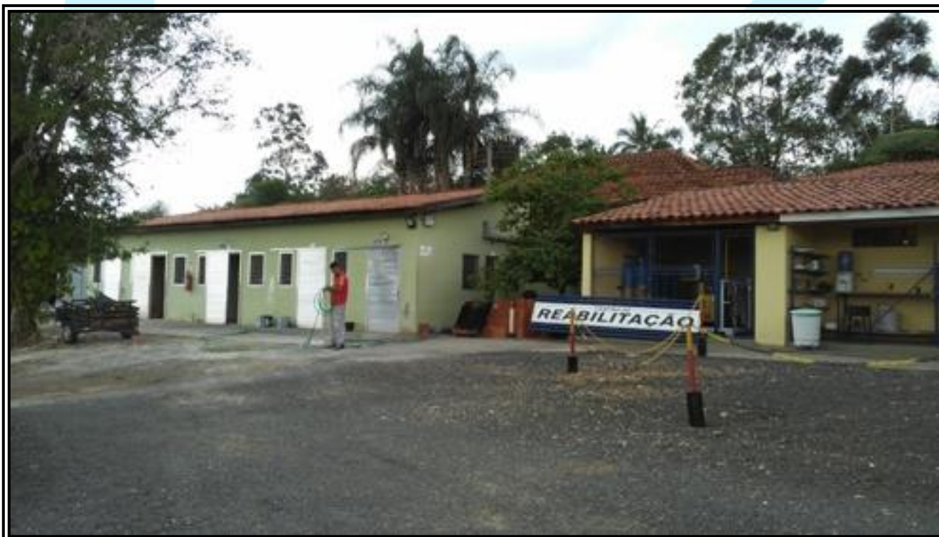
Oficina e Salas de Manutenção
