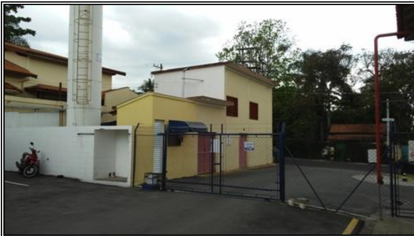
Portaria Funcionários e Cabine Primária
